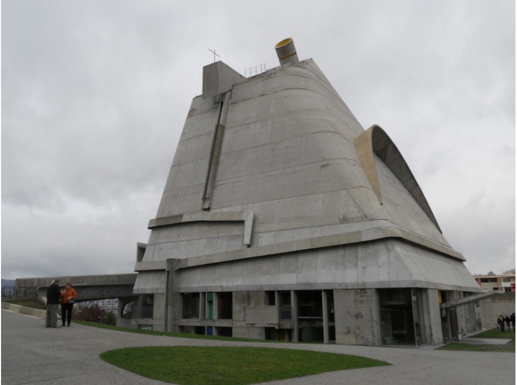
06. Exterior. Foto: Marcelo Payssé.
