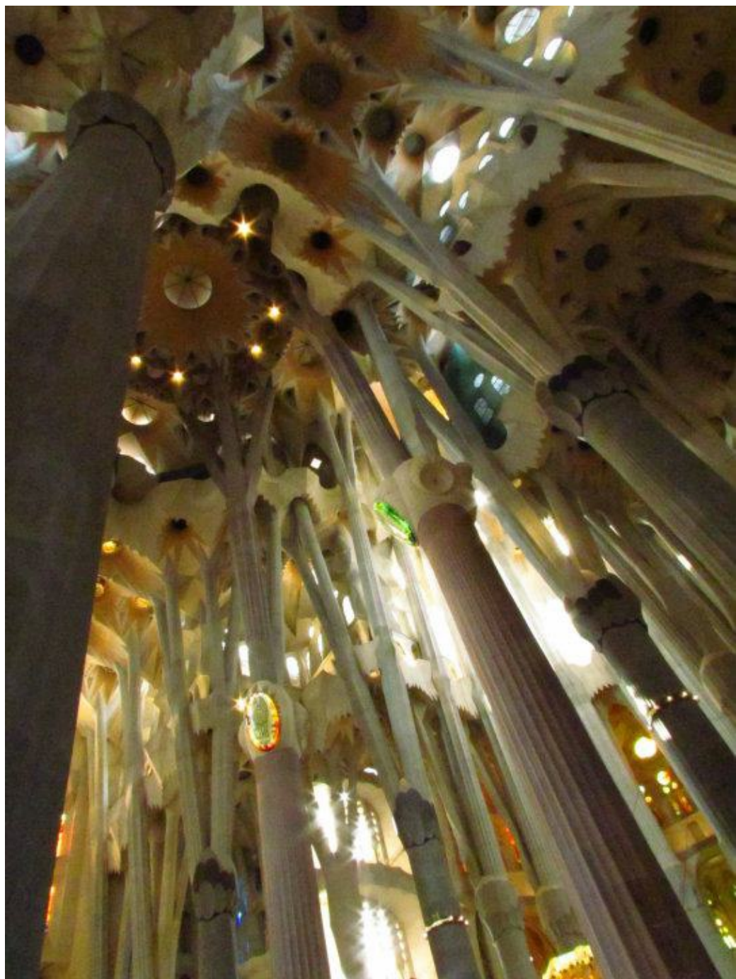
05. Interior de la nave. Foto: Juan Pablo Portillo.
