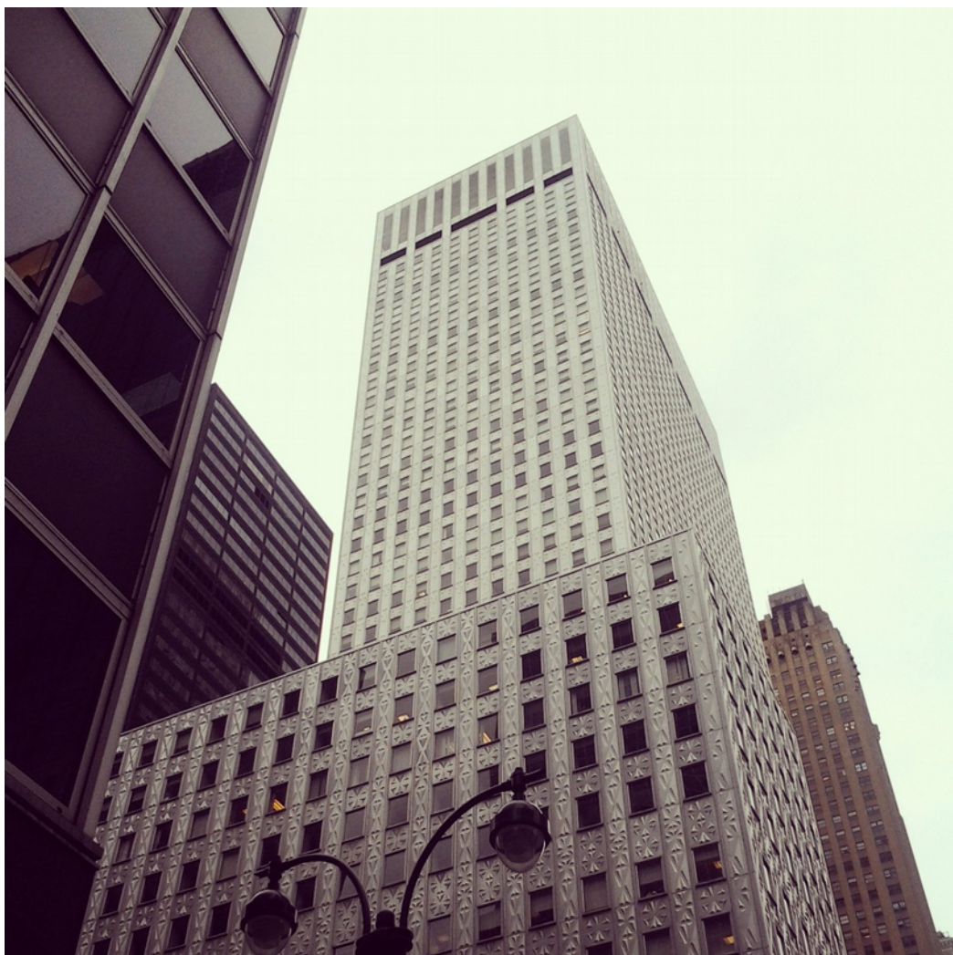
02. Nueva York. Socony-Mobil Building. Foto: Pablo Canén.
