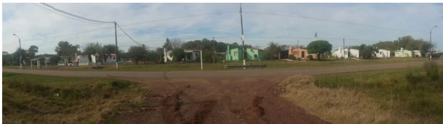
Viviendas ubicadas sobre el acceso a la villa.
