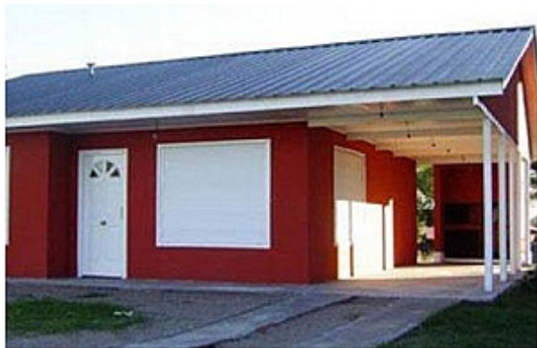
Fig 10. Fotografía de una vivienda prefabricada Empresa: Casa Propia
