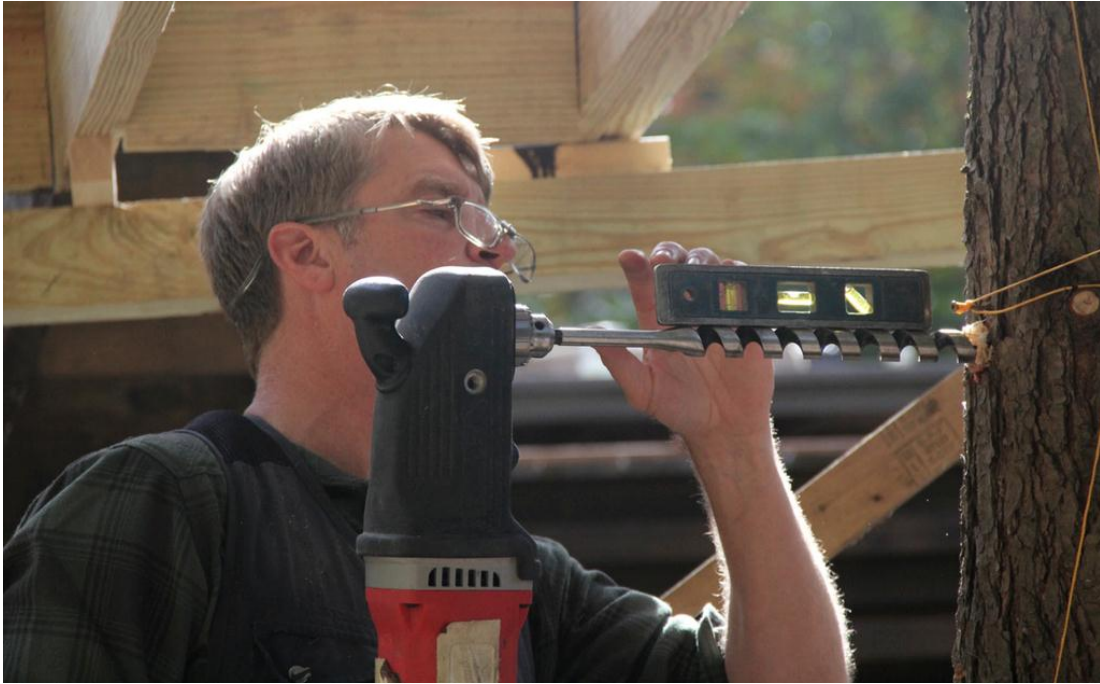
Hueco en árbol previa colocación del TAB.
