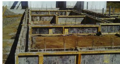
CIMENTACION VGAS DE HORMIGON ARMADO
