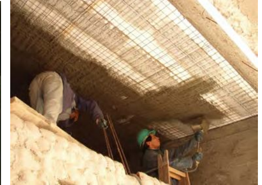
PROYECCION DE REVOQUE SOBRE CIELORRASO
