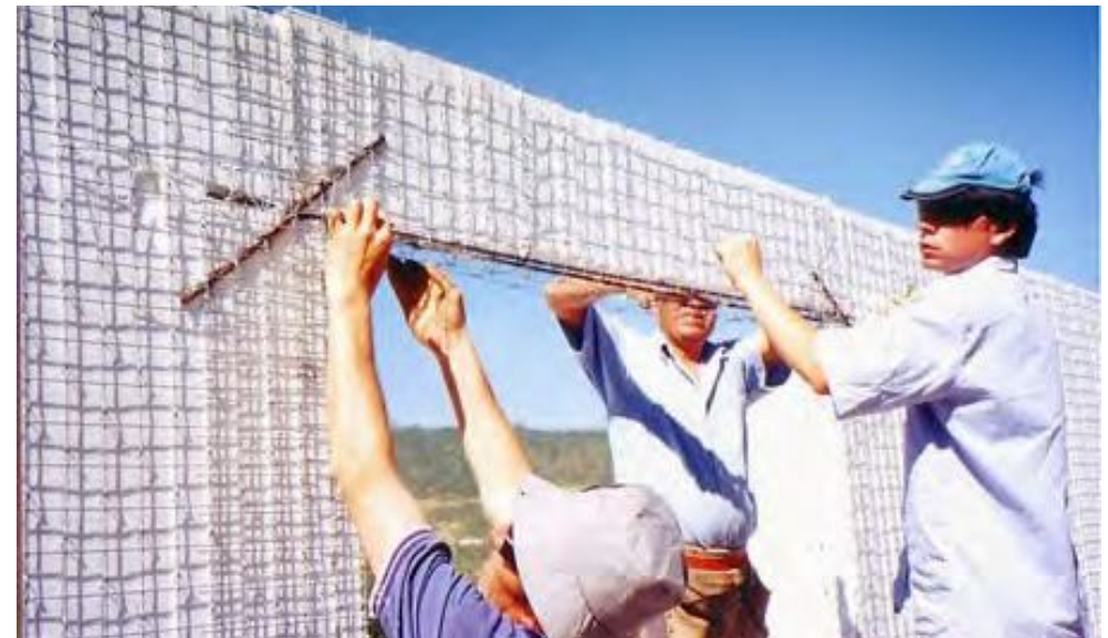
COLOCACION REFUERZO DINTEL DE ABERTURA
