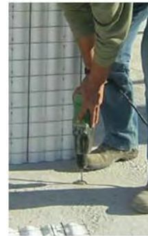
COLOCACION ANCLAJES POSTERIOR AL LLENADO
