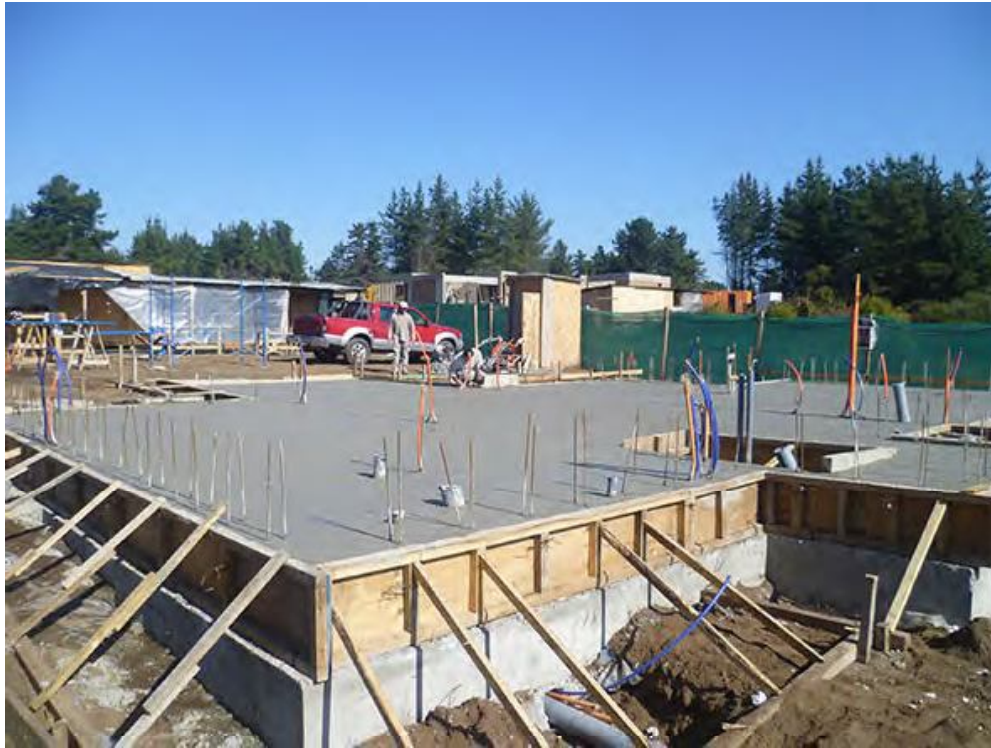
CIMENTACION PLATEA DE HORMIGON ARMADO
