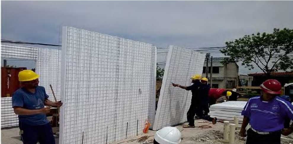
MONTAJE PANELES VERTICALES
