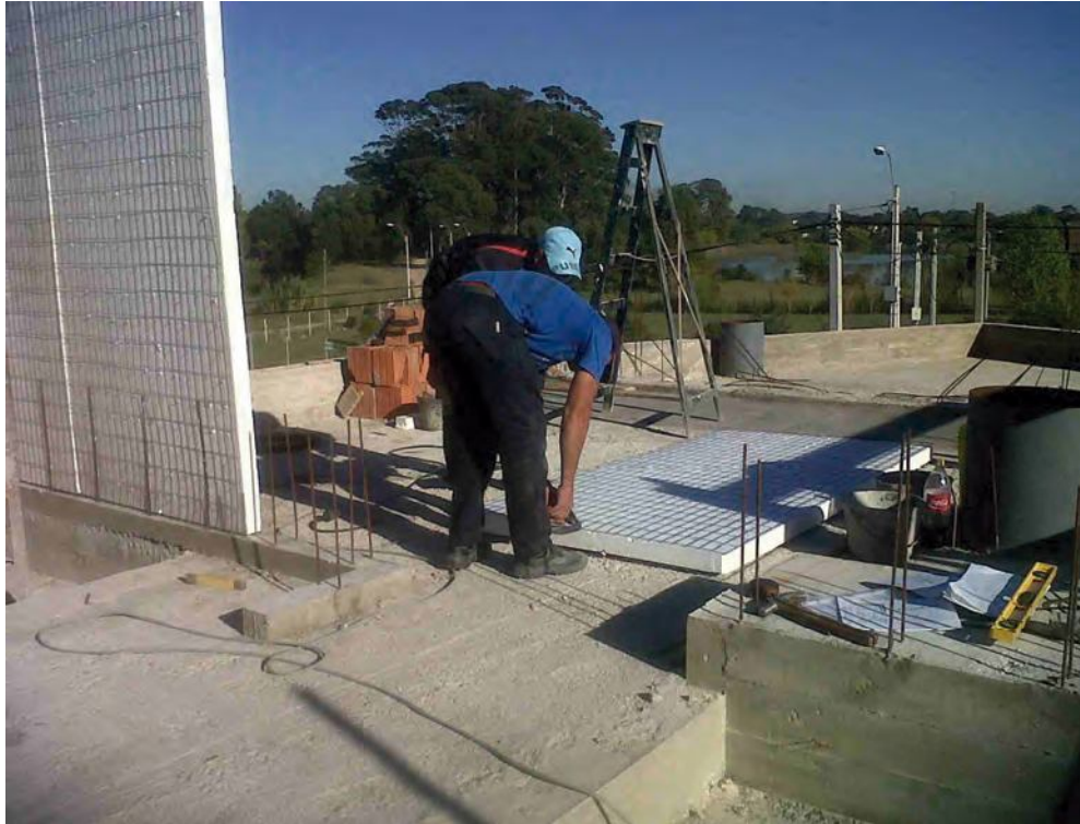
ANCLAJES EN VIGAS DE HORMIGON
