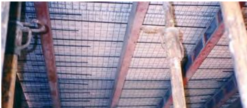
COLOCACION HIERROS REFUERZOS Y ARMADO EN LOSAS
