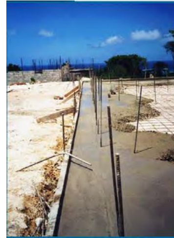
COLOCACION ANCLAJES PREVIO AL LLENADO
