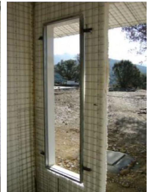
COLOCACION PRE MARCOS
