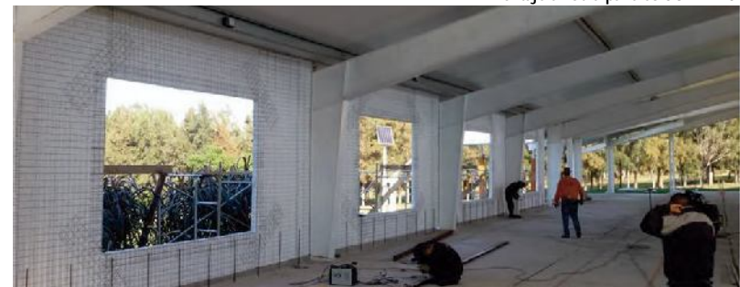
Montaje en obra paneles BROMYROS
