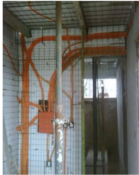
CANALIZACIONES ELLECTRICA COLOCADAS
