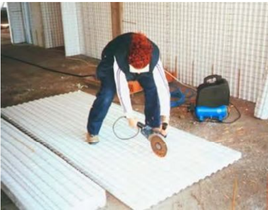
RECORTE DE ABERTURAS PREVIO A LA COLOCACION
