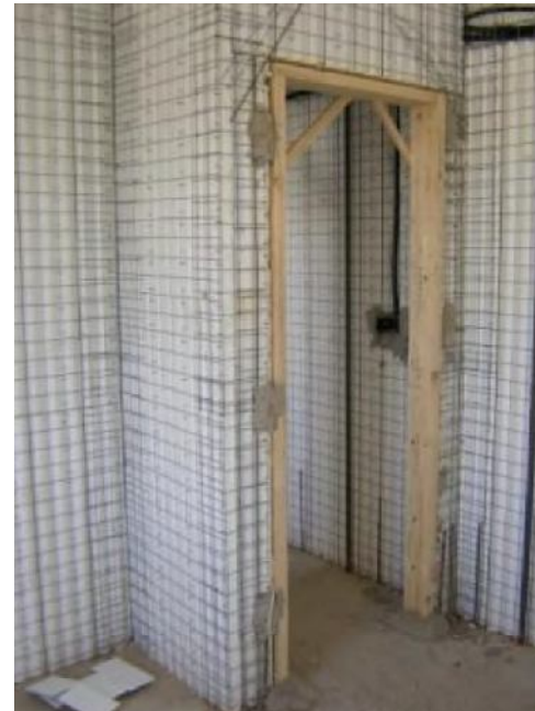
COLOCACION PRE MARCOS
