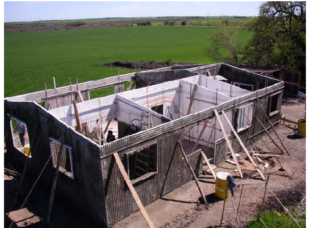
PROYECTACIÓN DE MORTERO EN CERRAMIENTOS VERTICALES
