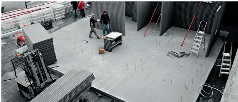
PLATEA DE HORMIGON ARMADO FINALIZADA
