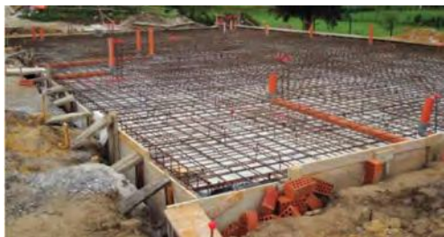
CIMENTACION PLATEA DE HORMIGON ARMADO
