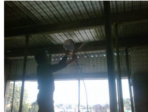
IMPREGNACION PREVIA AL MORTERO EN CIELORRASOS
