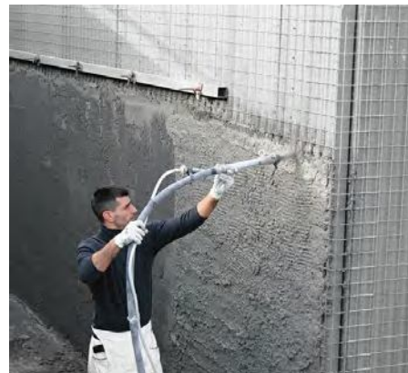
PROYECTACIÓN DE MORTERO
