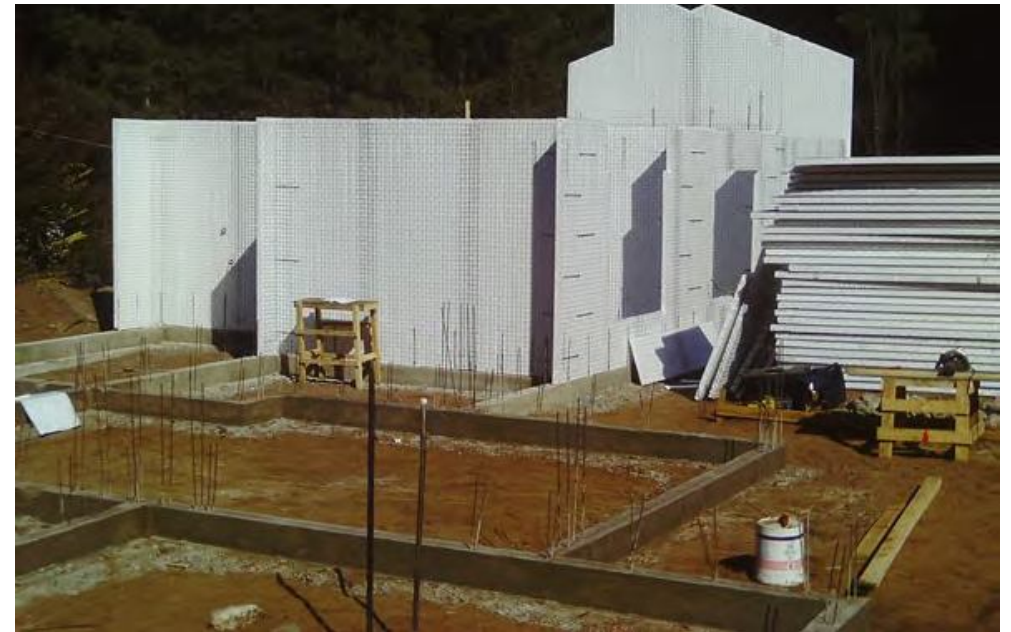
MONTAJE PANELES VERTICALES EN VIGAS
