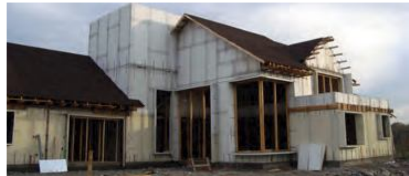
Montaje en obra paneles COVINTEC
