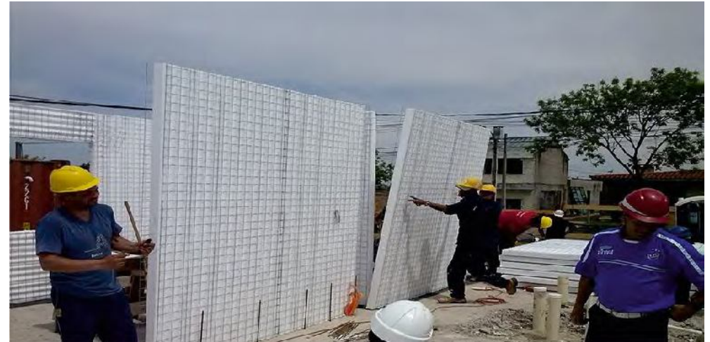
Casa de muestra, empresa BROMYROS, sistema CONCRESPUMA Montaje de paneles
