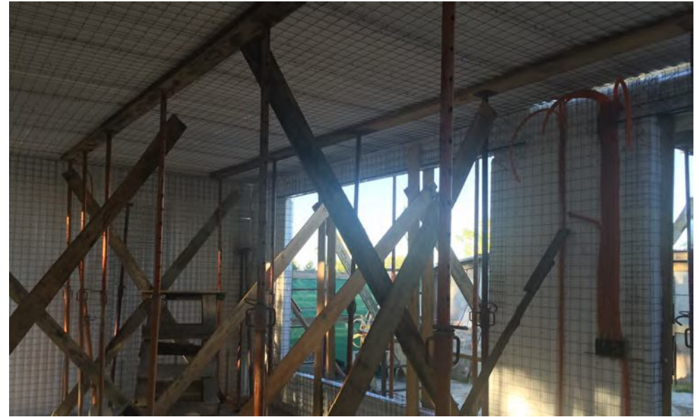
APUNTALAMIENTO DE PANELES LOSA
