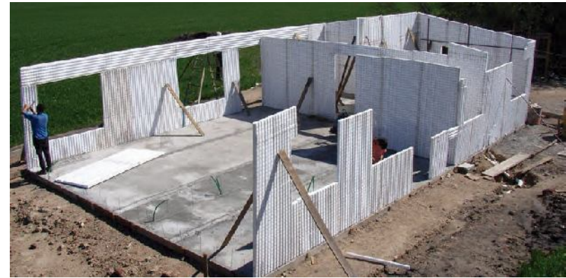
Montaje en obra paneles FRIDULSA
