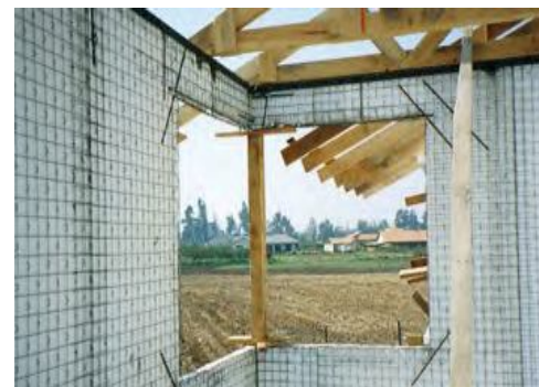
COLOCACION PRE MARCOS
