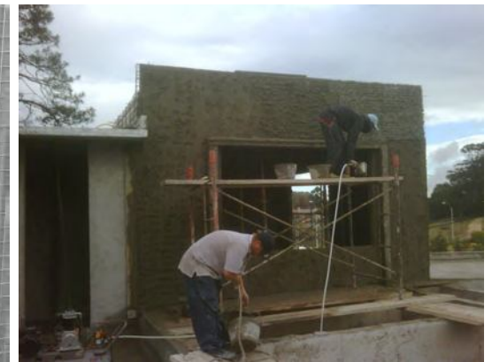
PROYECTACIÓN DE MORTERO
