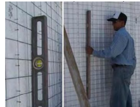
NIVELACION PANEL MURO CON NIVEL DE MANO
