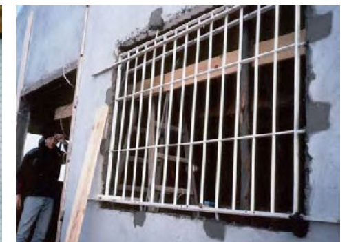
COLOCACION REJAS ABERTURAS
