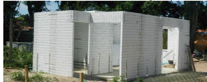
Montaje en obra paneles IGABEN SA
