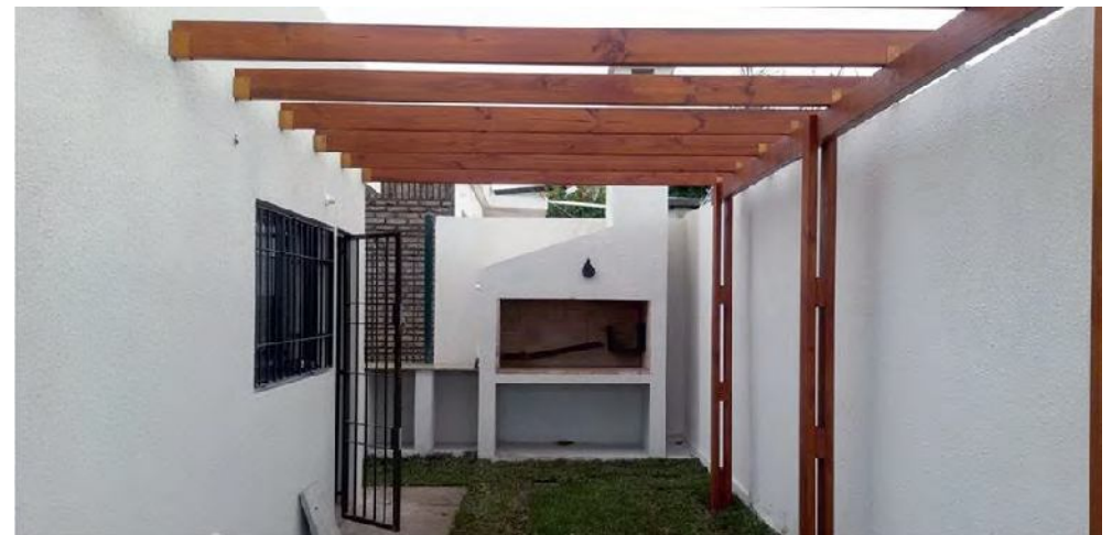
Casa de muestra, empresa BROMYROS, sistema CONCRESPUMA Casa terminada
