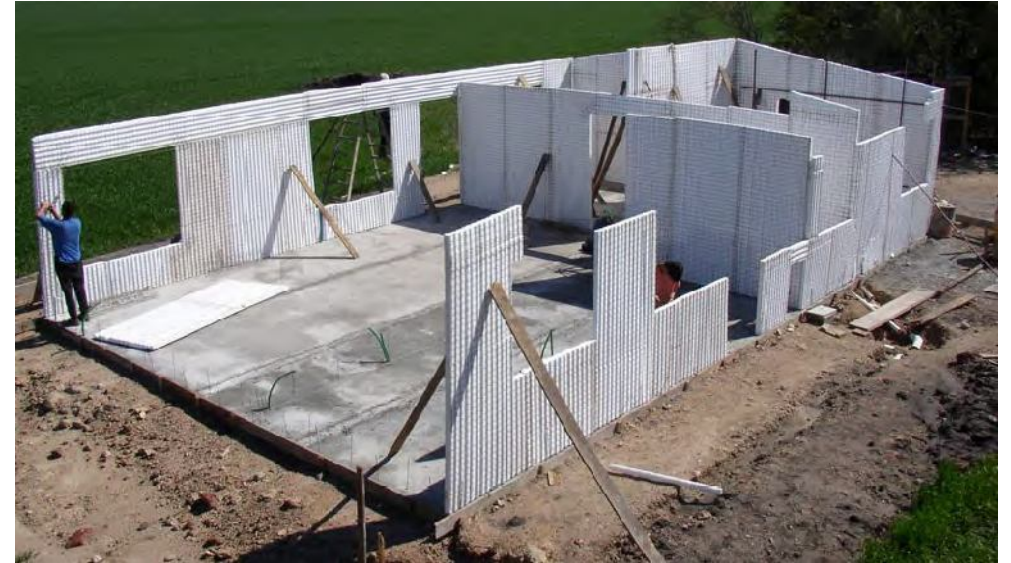
MONTAJE PANELES VERTICALES EN PLATEA
