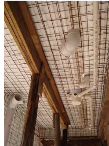
INSTALACION SANITARIA SUSPENDIDA DESAGUE
