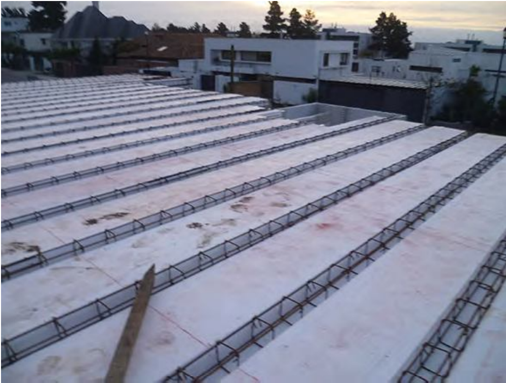
HIERROS EN VIGUETAS PANEL LOSA EMMEDUE
