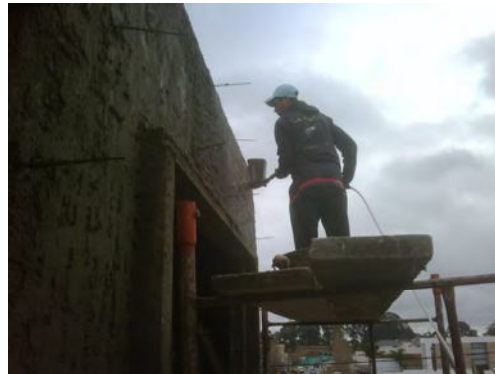
PROYECTACIÓN DE MORTERO
