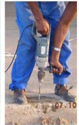
COLOCACION ANCLAJES POSTERIOR AL LLENADO
