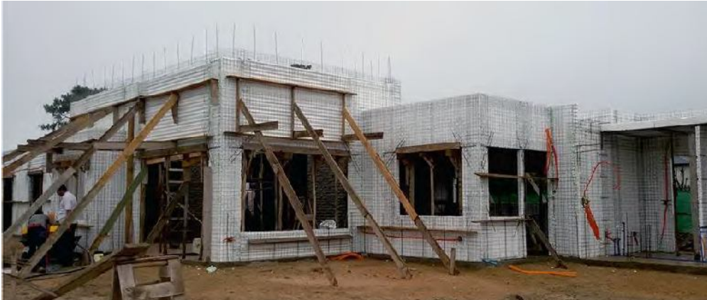
APUNTALAMIENTO DE PANELES
