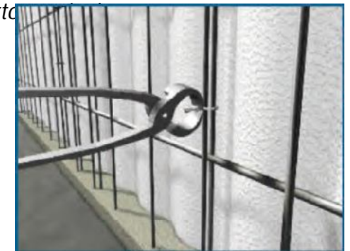
UNION DE PANELES VERTICALES CON ALAMBRE
