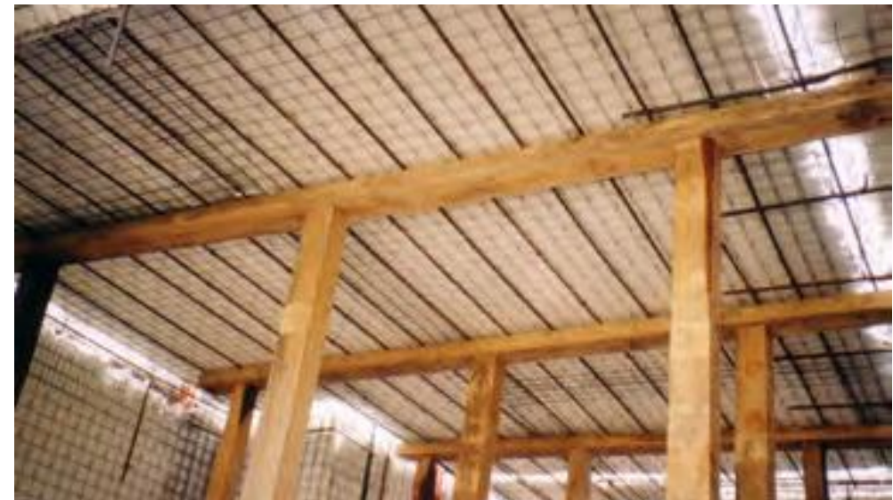
APUNTALAMIENTO DE PANELES LOSA
