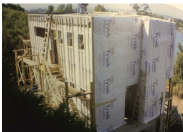
Figura 18-Colocacion del Tyvek [Fuente: Ricardo Hempel. (2008). "Sistema Constructivo de Madera Solida" . Chile : Universidad del BIO BIO.]
