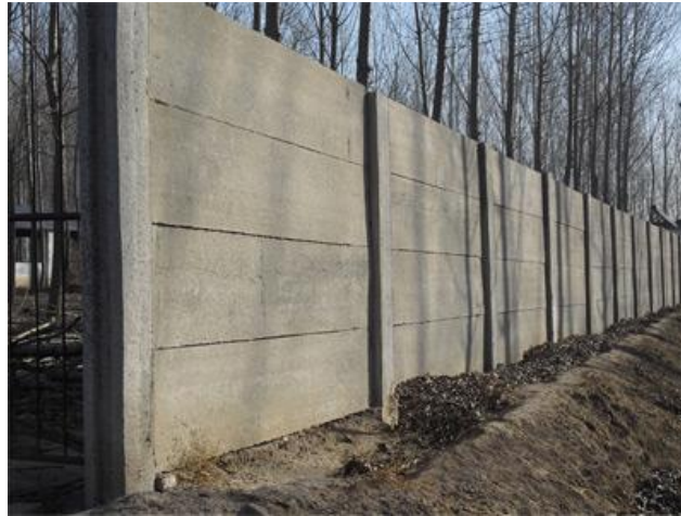
8-1 Muro [Fuente: web de Hopresa]
