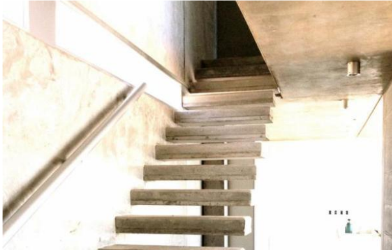
Figura 1-2. Elementos prefabricados para escalones
