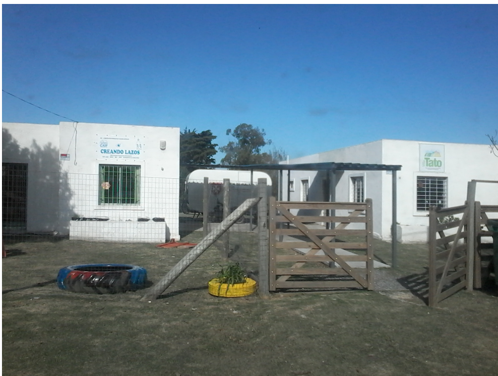
Fotografía de Salón Comunal, Policlínica y CAIF de Villa del Tato, tomada en observación de campo Mayo 2015
