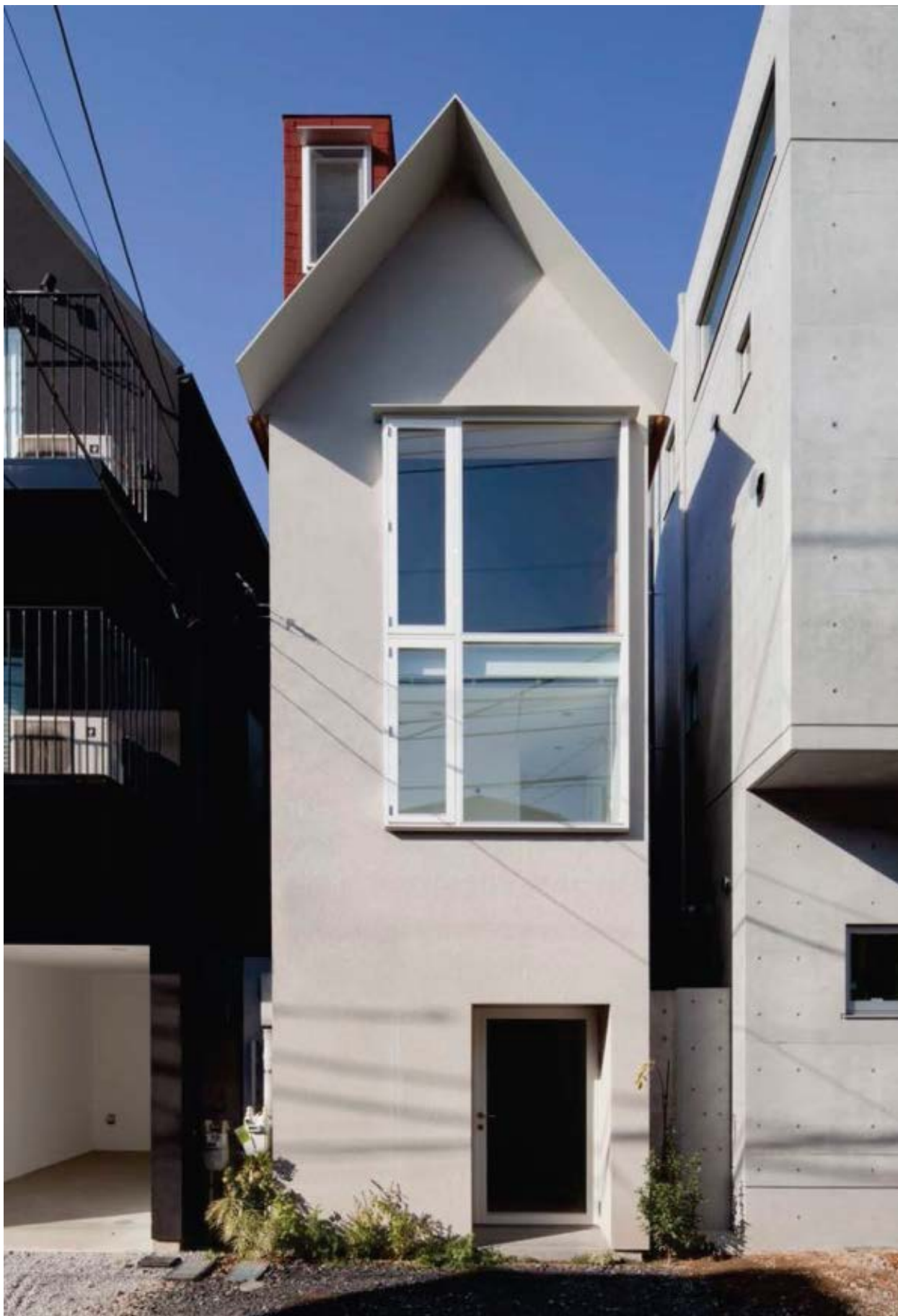
Atelier Bow Wow, Split Machiya House en Tokio. Fotografía tomada de japplusu.com, 2016.
