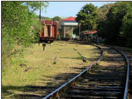
IMAGEN 22: ESTACIÓN DE TRENES, VALLE EDÉN
