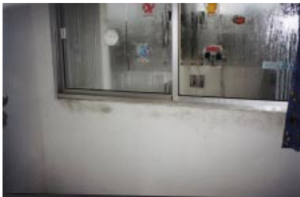
Fig.4.8- Condensación en vidrios.
