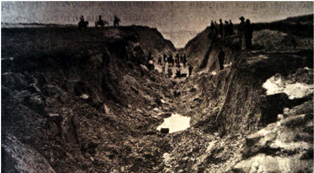
Figura 35.- Detalle de las obras de apertura del Canal N° 1. Fuente: Araujo, 1900.
