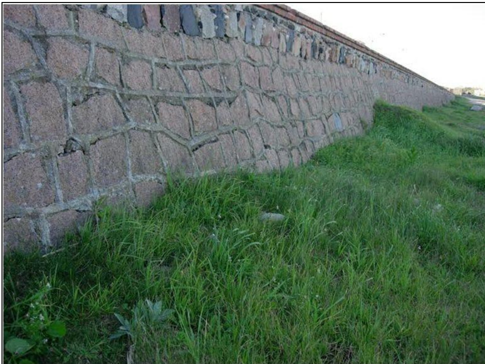
Figura 6: Zona norte: se observa el muro y la sombra que proporciona así como también el tipo de vegetación circundante.
