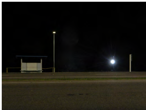
Iluminación de la parada de omnibus sobre la Ruta Interbalnearia
