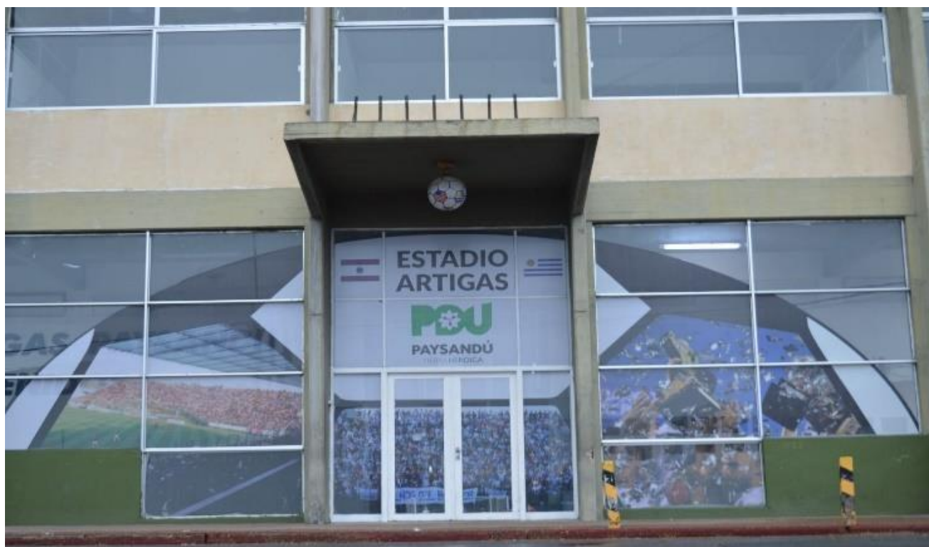
Fotografía 4: Fotografía de la entrada del Estadio Artigas
