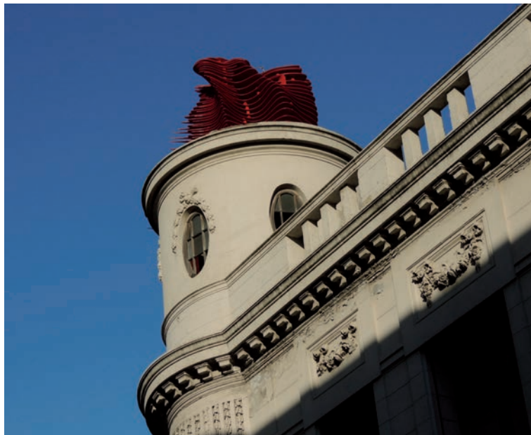
Figura 5. Cúpula colocada en sitio
