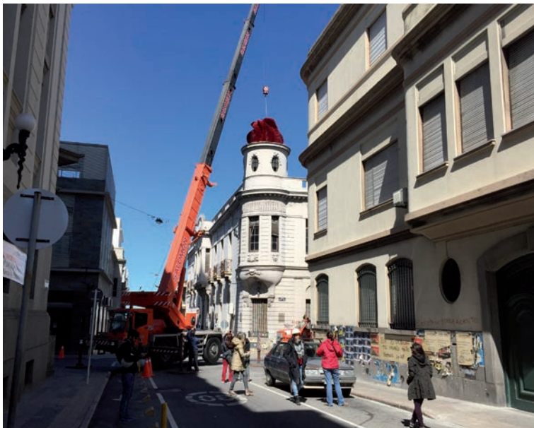
Figura 6. Montaje en sitio
